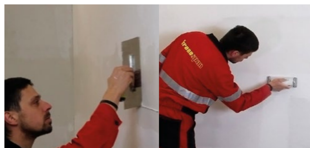
Obrázek č. 7: Vrchní tmelení; broušení tmelu Firestop finish (pokud je to nutné).
